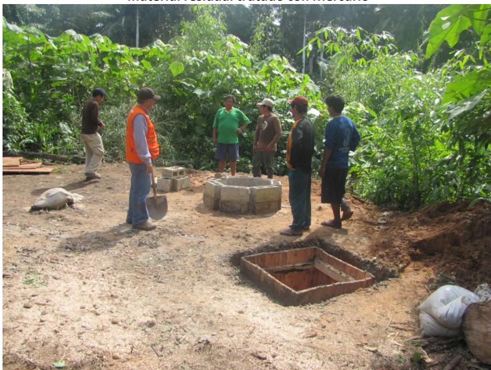
Figura N° 48 – Tanque de Lavado de arenas con mercurio y Pozo para confinamiento del material residual tratado con Mercurio
