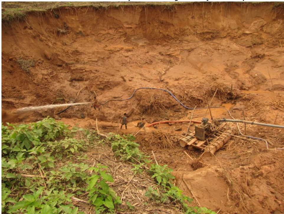
Figura N° 47 – Actividad Artesanal que causa Gran Impacto Ambiental y de Alto riesgo para el personal – Desestabilización de suelo y taludes - Aguas abajo de Campamento Yarinal
